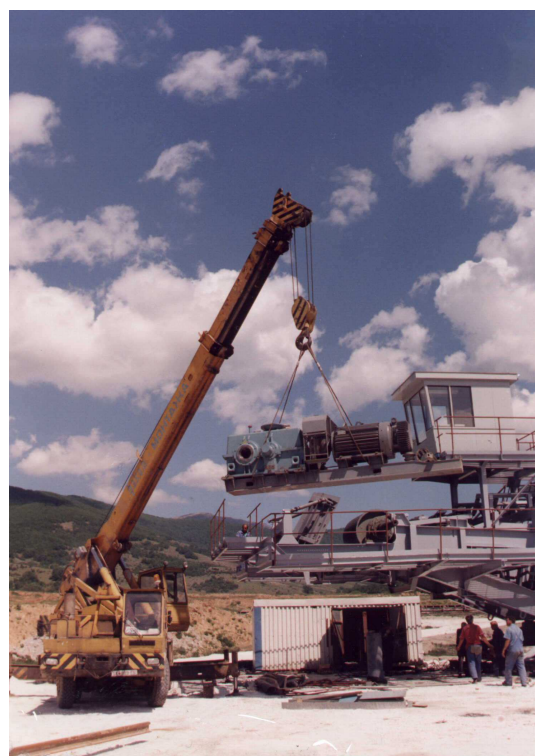
Montáž poháněcí jednotky
